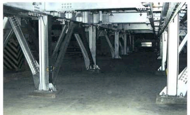
■ OAフロア下、クリーンルーム、工場
