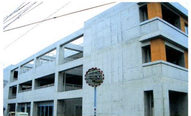
■ コンクリート壁、ブロック塀
